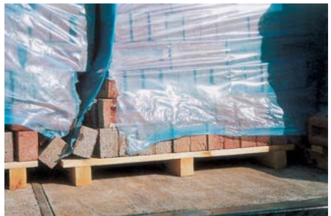
Eine Schrumpffolie ist nicht in der Lage, schwere Steine auf einer Palette zu sichern.
