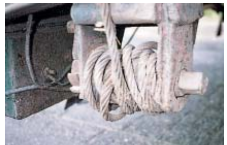
Wegen der „Luftschlaufen“ kann das Seil nachrutschen und dadurch seine Vorspannkraft verlieren.
