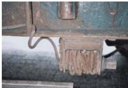
Dieses Zurrdrahtseil und die Wickelwelle sind wegen der Witterungseinflüsse stark verrostet.
