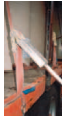
Der Einsatz einer Ratschenverlängerung kann schwere Verletzungen zur Folge haben.
