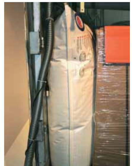
Der Luftsack wird so lange befüllt, bis er den Zwischenraum ausfüllt.
