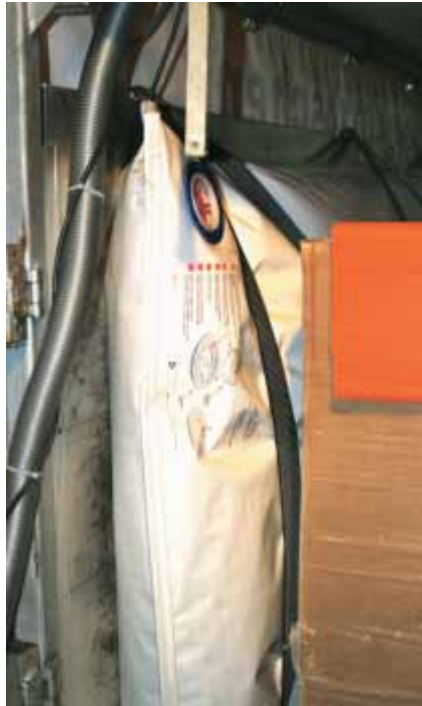
Die Luft wird automatisch durch den Druck der Gummibänder aus dem Luftsack gepresst.
