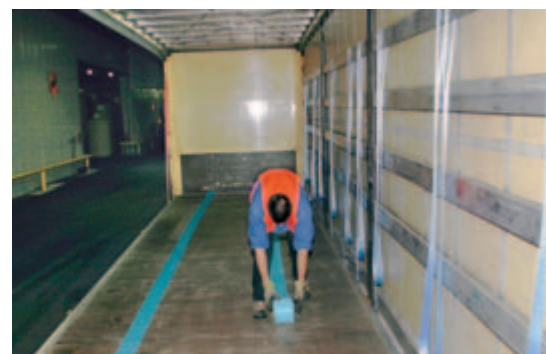
Ausrollen des rutschhemmenden Materials
