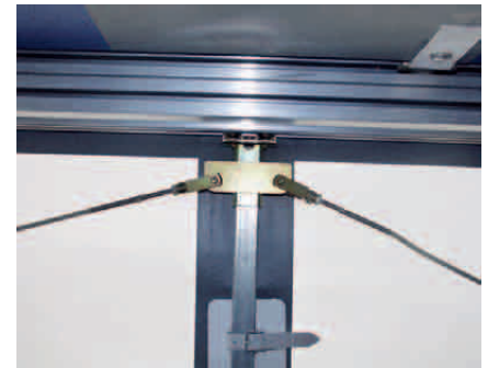
Die Seile stören nicht, denn sie können mit dem Dach zusammen aufgeschoben werden.
