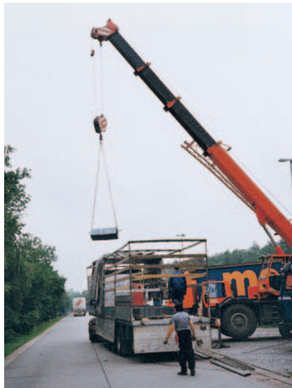
...wurde per Kran umgeladen...
