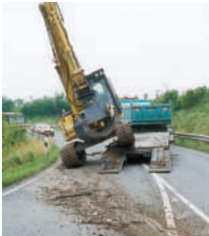
Durch diesen Unfall musste die Autobahnauffahrt in beiden Richtungen gesperrt werden.
