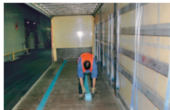
Ausrollen des rutschhemmenden Materials
