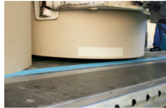
Das punktgenaue Absetzen ist Präzisionsarbeit.
