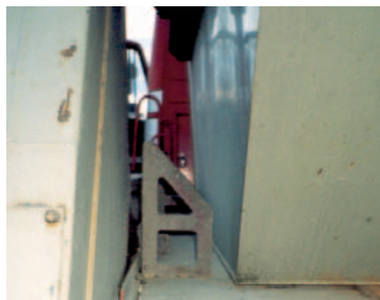
Formschlüssige Sicherung eines Absetzbehälters zur Seite. Der Abstand zu den Anschlägen ist nur gering und kann akzeptiert werden.
